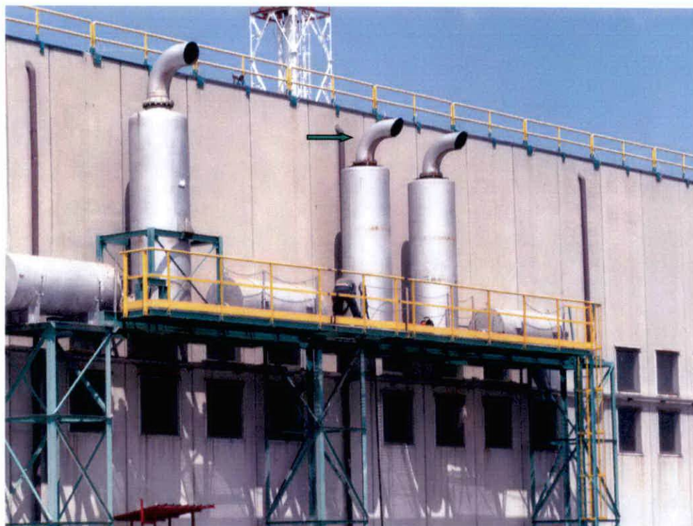
Foto 1: Punto di emissione E14 (camino indicato dalla freccia di colore verde)
