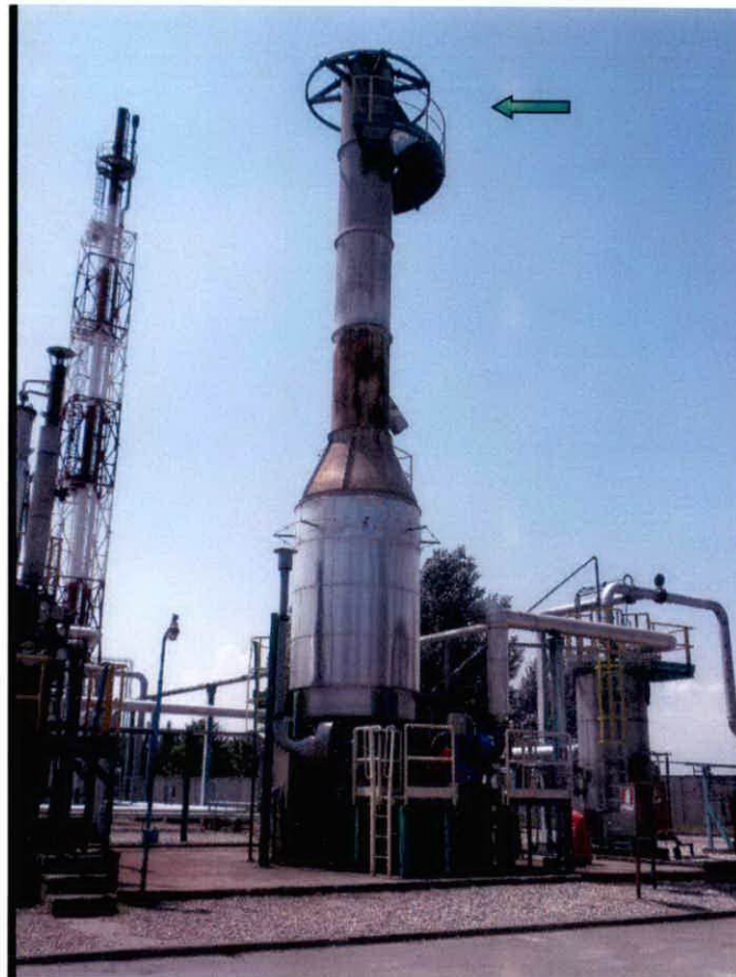
Foto 3: Punto di emissione E01 (camino indicato dalla freccia di colore verde)
