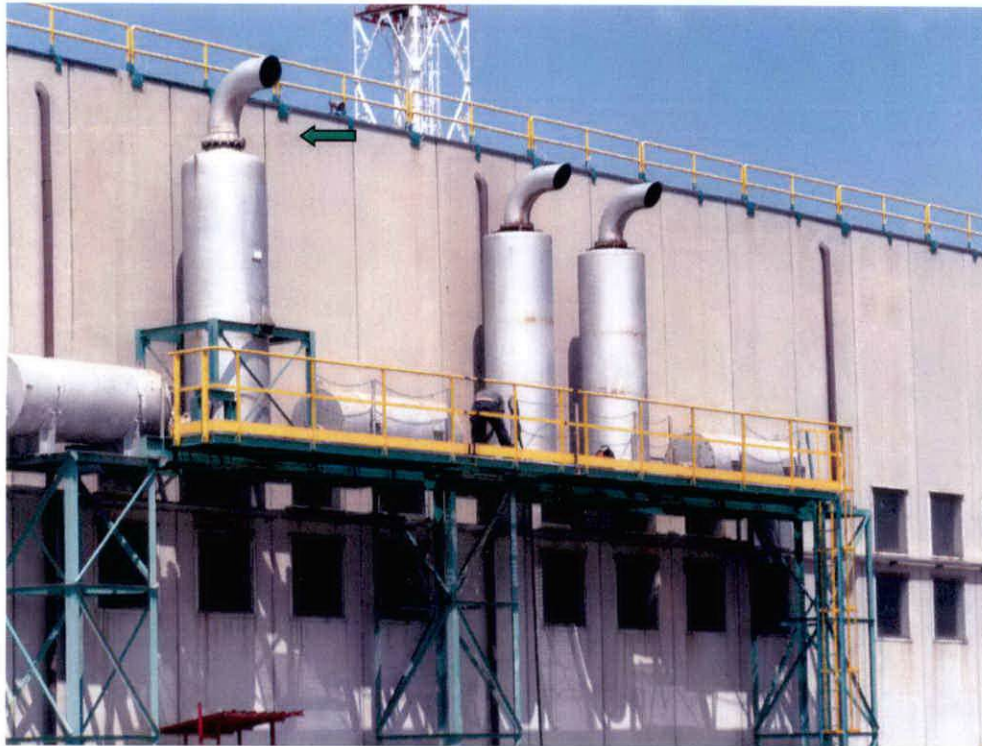
Foto 2: Punto di emissione E15 (camino indicato dalla freccia di colore verde)
