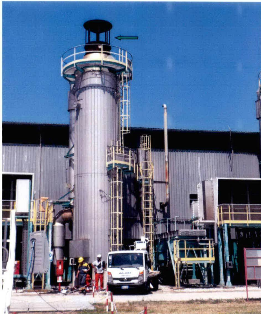
Punto di emissione E19/a (camino indicato dalla freccia di colore verde)
