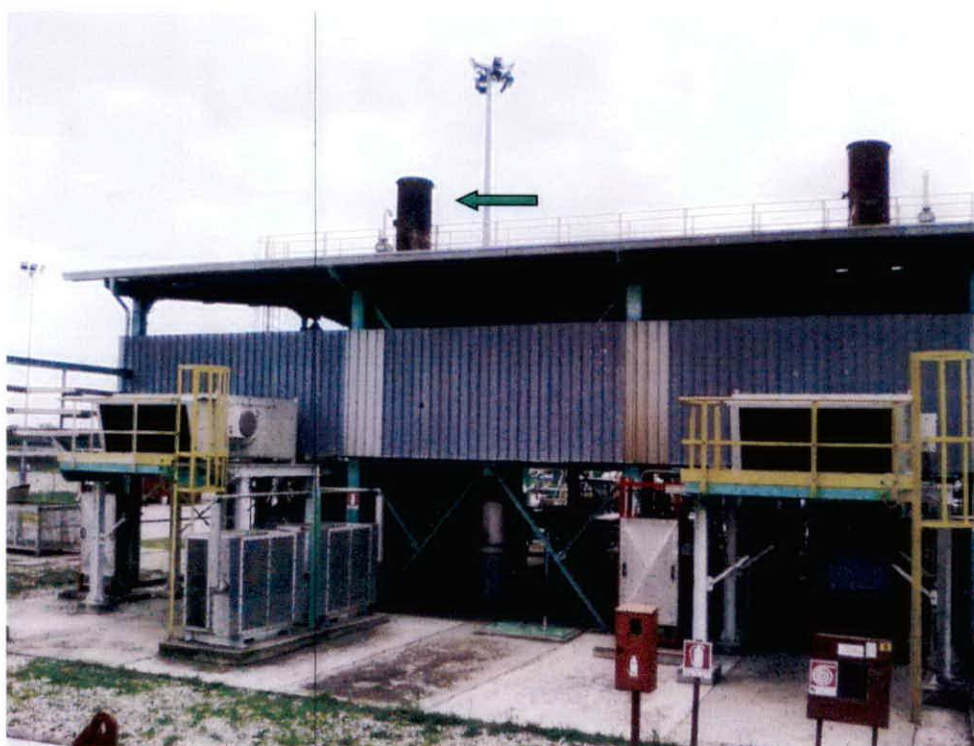
Punto di emissione E15/a (camino indicato dalla freccia di colore verde)
