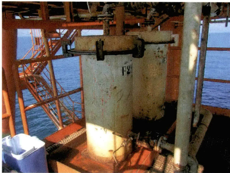
Foto 2 - Impianto di trattamento con filtri a carbone attivo
