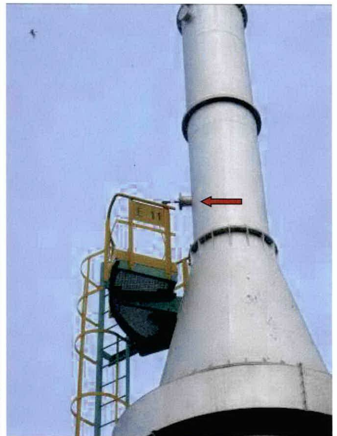
Punto di campionamento con sonda di prelievo
